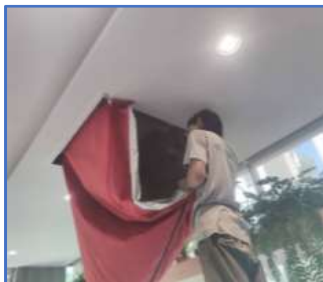
รูปที่ 40 เจ้าหน้าที่ตรวจสอบช่องระบายอากาศ
